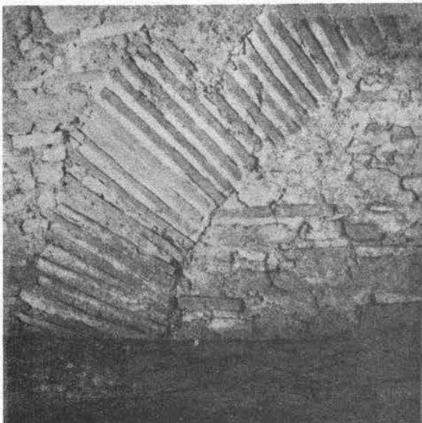
Fig. 40.— S. ANASTASIA — Arco di scarico nell'abside.
